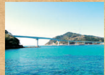
伊王島 平成23年3月に香焼町と伊王島町を結ぶ橋長876mの橋が完成しました。
